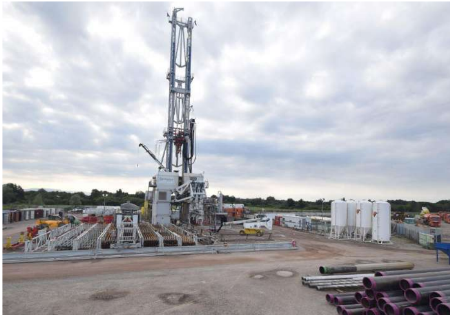
Figure 5: Photo du nouveau RIG B04 450T appartenant à Georhin pour le 2 nd forage sur le secteur de Vendenheim.
