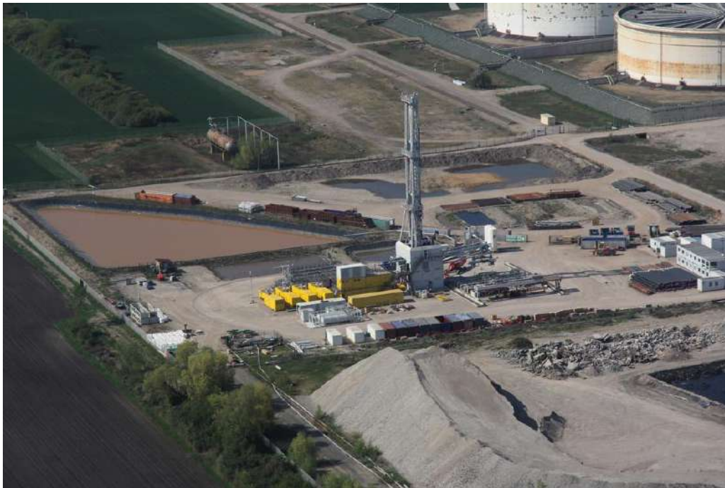
Figure 4: Rig B04 de 450 tonnes (site de vendenheim).
