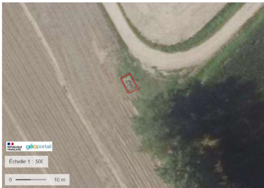
Figure 12: Photographie aérienne de la gare racleur (cadre rouge)
