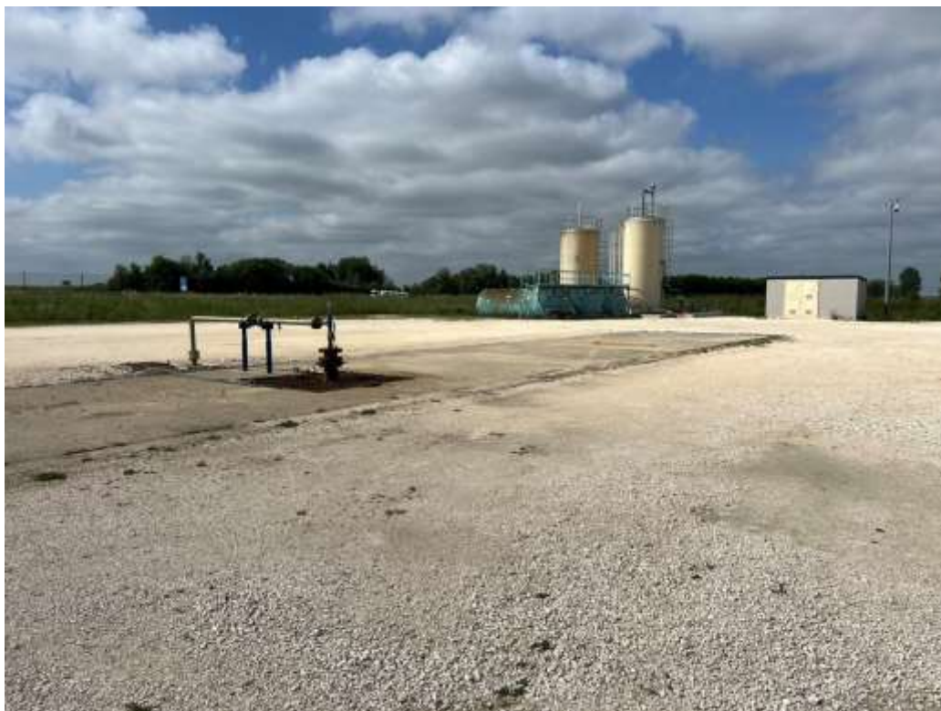
Figure 18 : Photographie du site IG 1
