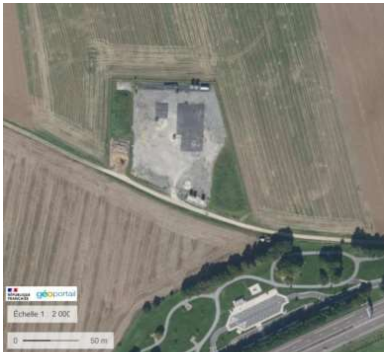
Figure 9 : Photographie aérienne de la plateforme MIL 2 (date de prise de vue avant le forage des 2 puits MIL-102 et MIL-202)
