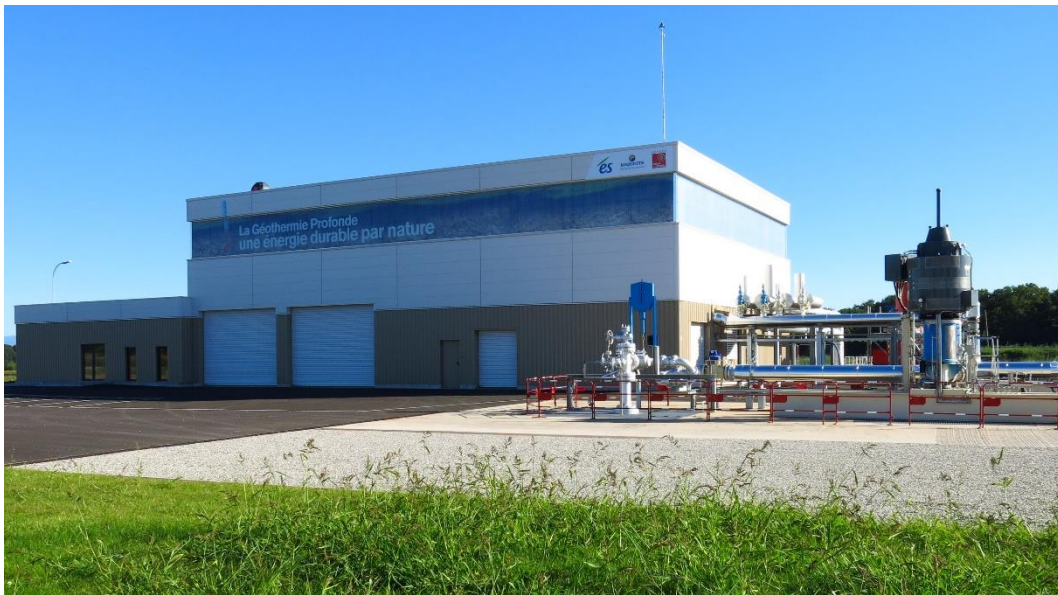
Figure 2 : Centrale de Rittershoffen
