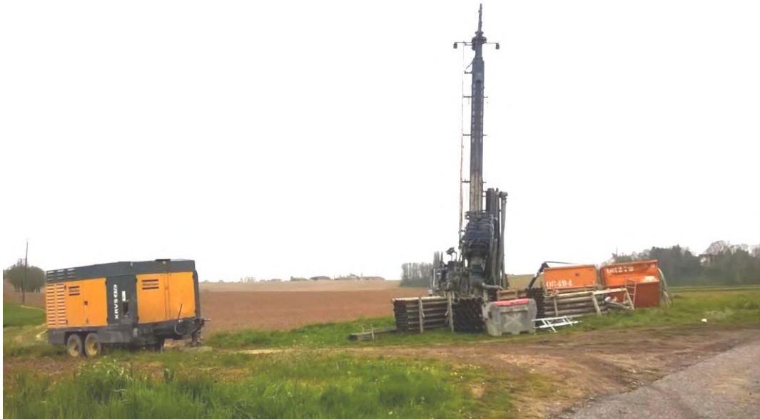
Figure 11 Exemple d'un chantier de forage de gradient réalisé
