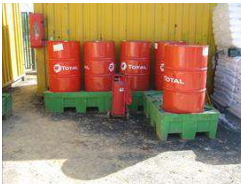
Figure 36 : Bacs de rétention et stockage d'huile sur un chantier
