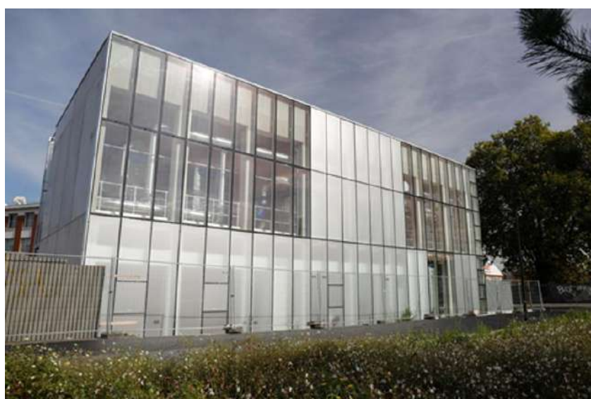
Figure 31 : Exemple de centrale géothermique
