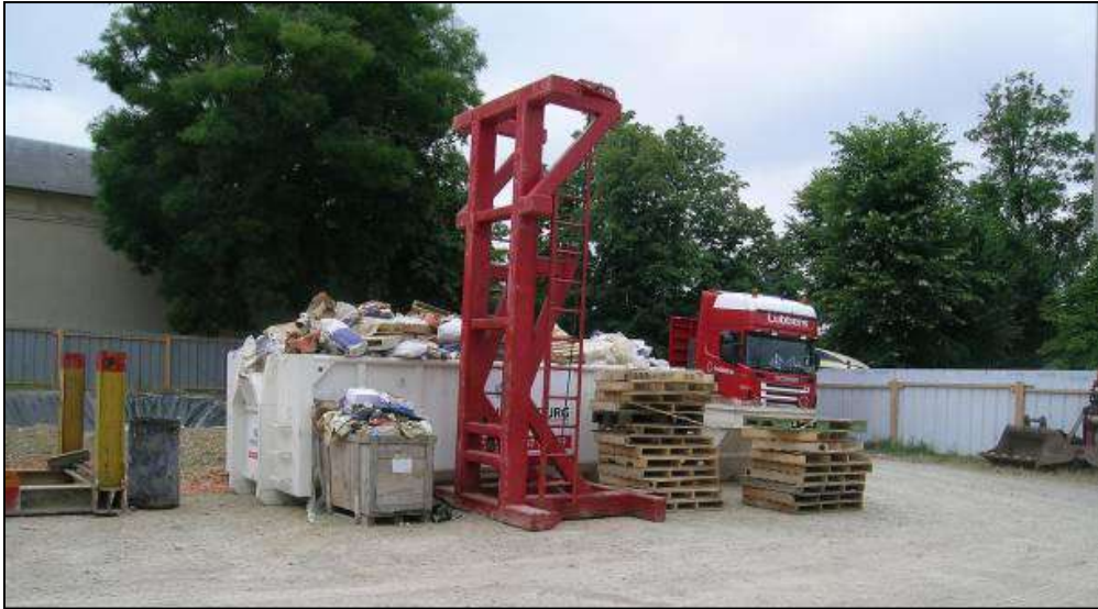
Figure 35 : Stockage des déchets sur un site
