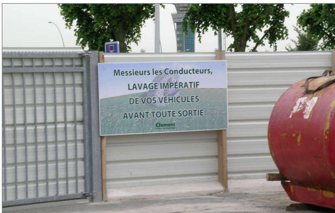
Figure 33 : Zone de nettoyage des véhicules d'un chantier
