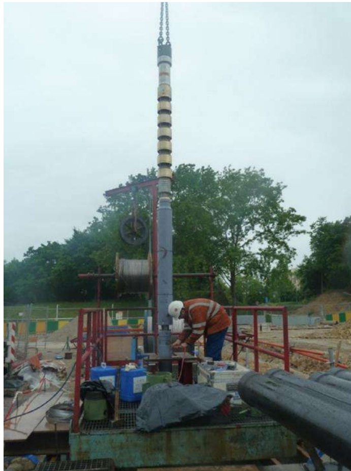
Photo d'un groupe de pompage immergé
