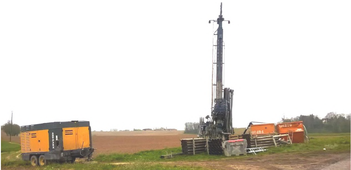
Figure 8 Exemple d'un chantier de forage de gradient réalisé
