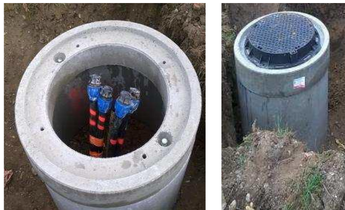
Figure 9 Exemple d'un chantier de forage de gradient réalisé et pérennisé en surface
