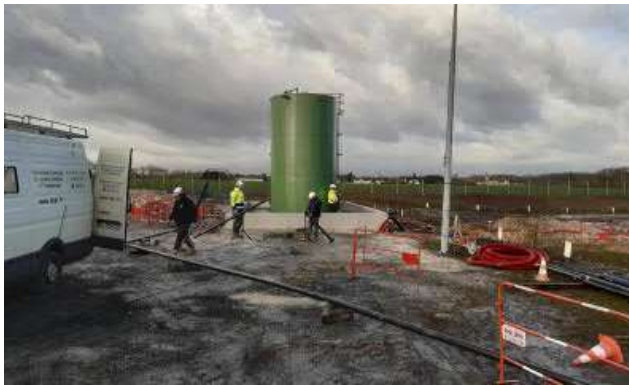
Figure 41 : Mise en place tuyauteries enterrées
