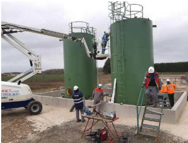
Figure 43 : Mise en place des accessoires de bacs de stockage
