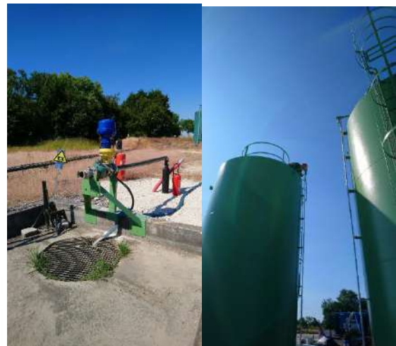
Figure 44 : Finalisation de la mise en place des nouveaux équipements
