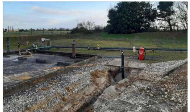
Figure 42 : Installation de la ligne allant du stockage à l'aire de chargement
