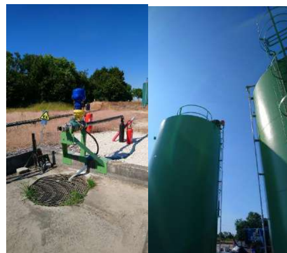
Figure 42 : Finalisation de la mise en place des nouveaux équipements
