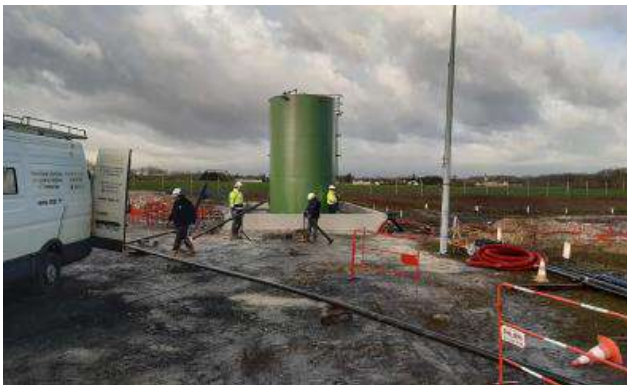
Figure 39 : Mise en place tuyauteries enterrées
