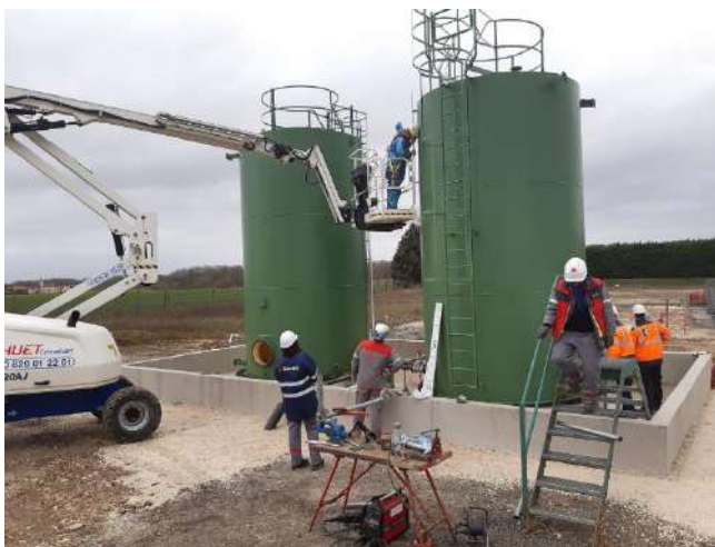
Figure 41 : Mise en place des accessoires de bacs de stockage
