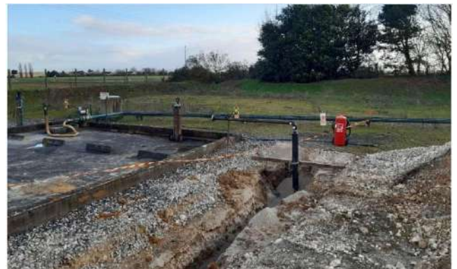
Figure 40 : Installation de la ligne allant du stockage à l'aire de chargement
