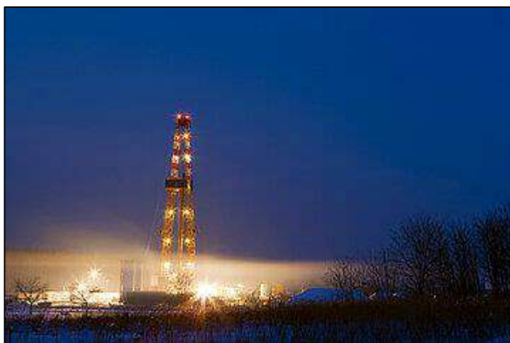
Figure 126 : Derrick d'un forage pétrolier en Sibérie éclairé de nuit
