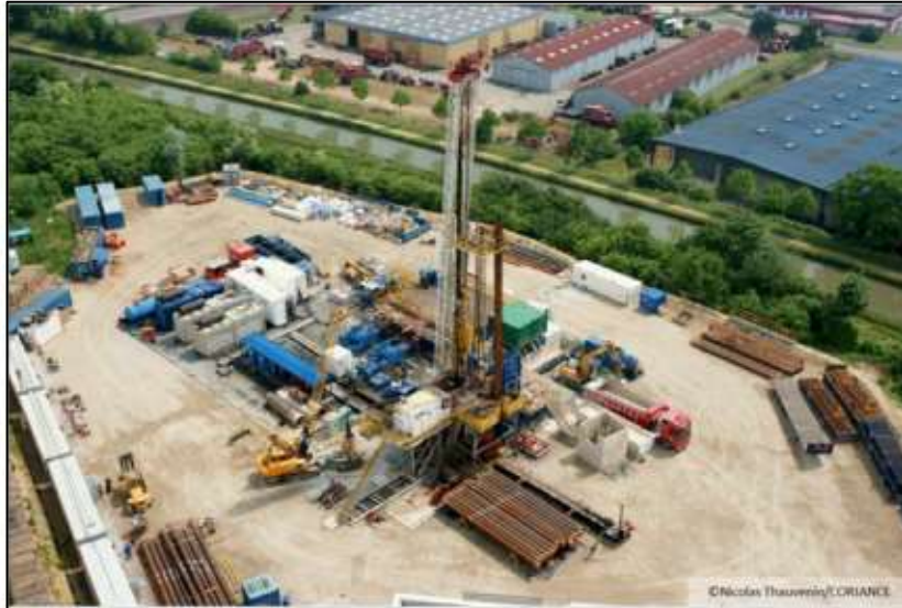
Figure 122 : chantier de forage de Meaux Beauval
