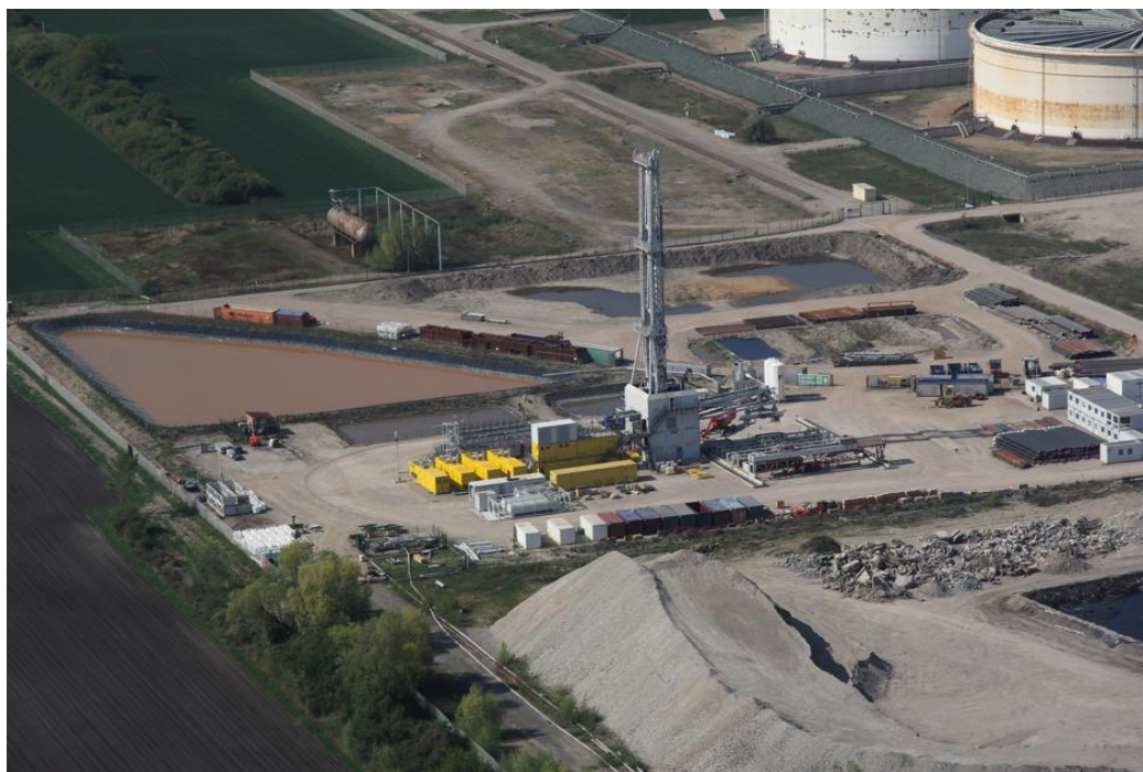
Figure 4: Rig B04 de 450 tonnes (ici sur le site de Vendenheim en Alsace).
