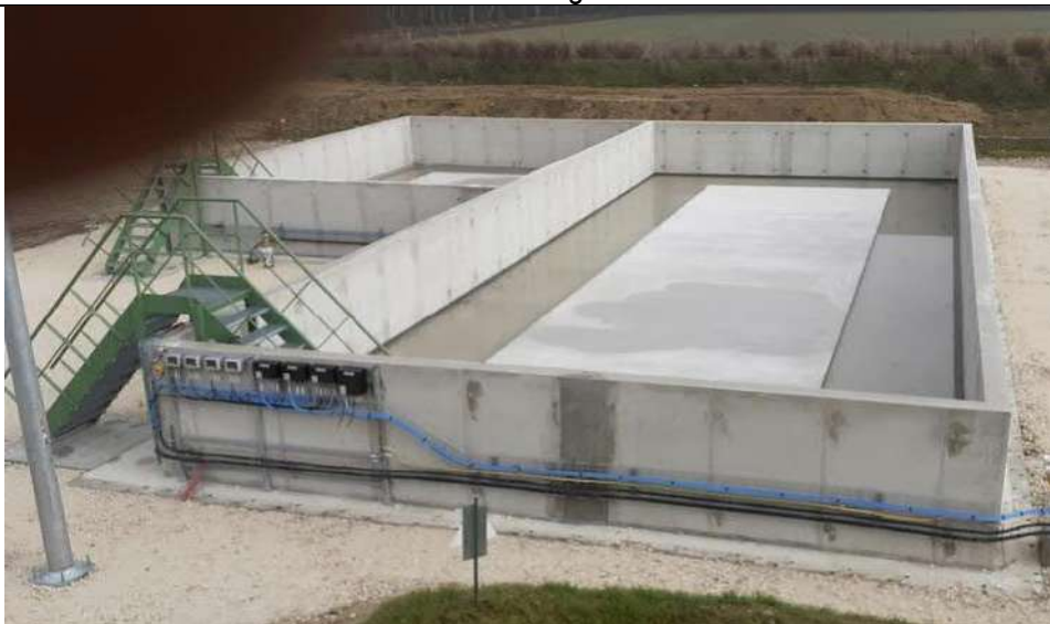
Rétentions avant pose des bacs
