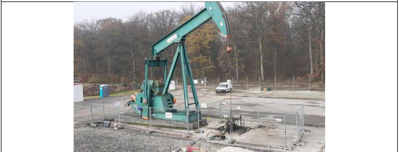
Unité de pompage
