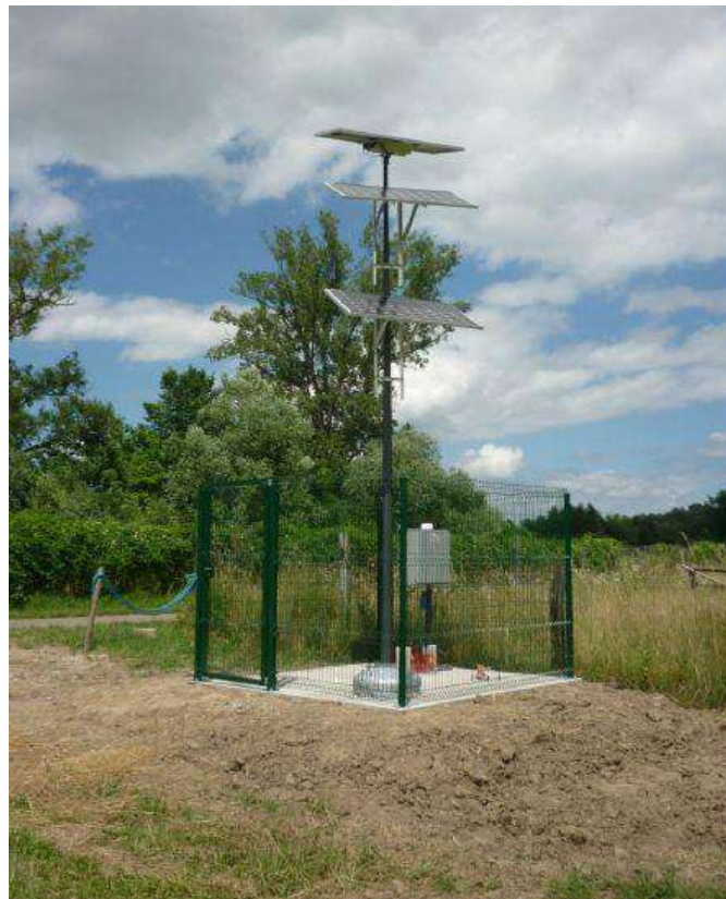
Figure 14: Exemple d'une station de surveillance sismique
