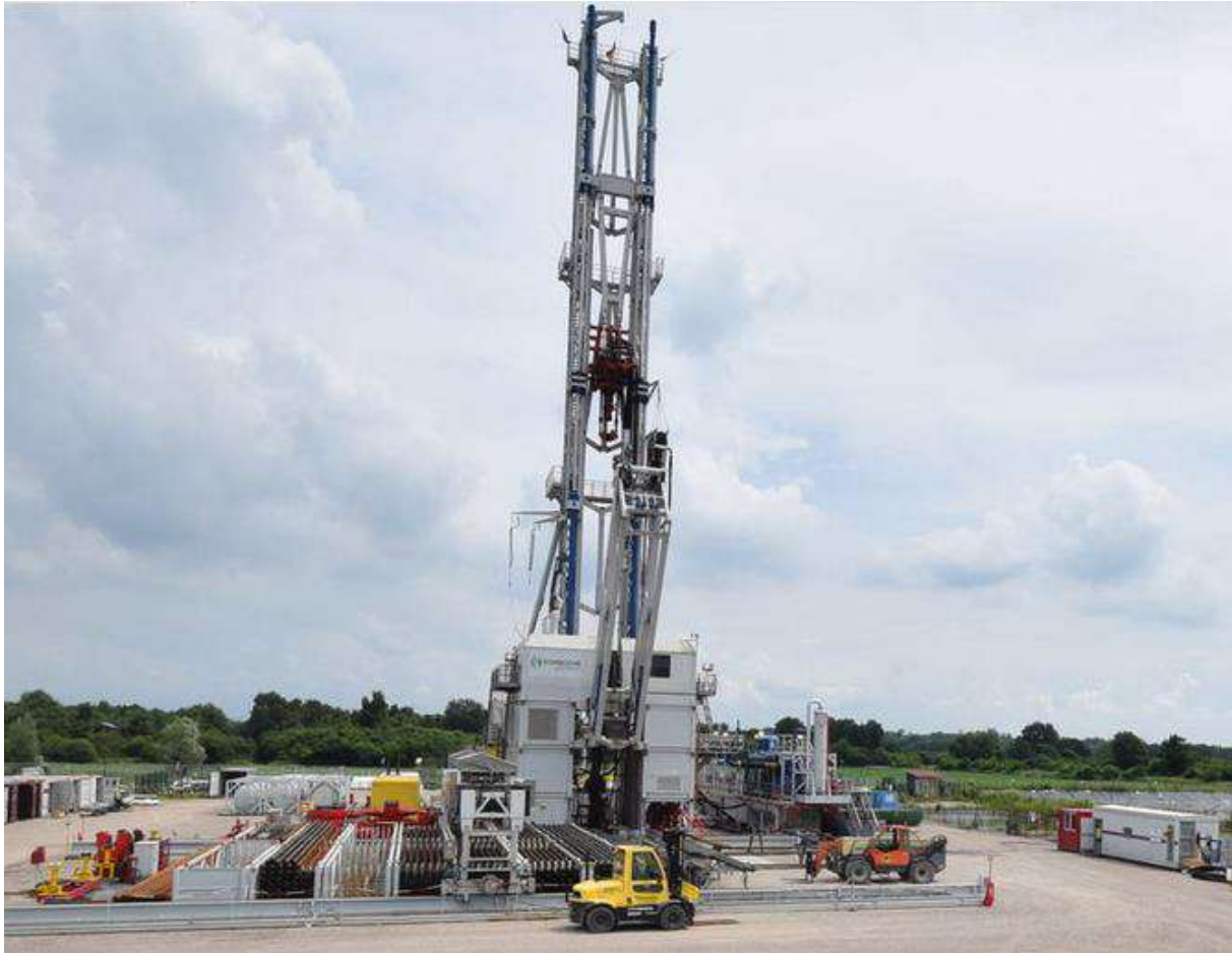
Figure 9 : Exemple d'atelier de forage, ici le rig B04 450 T sur le projet de Vendenheim
